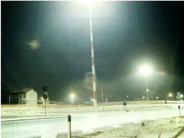
*Svincoli di grandi infrastrutture: Impianto di faraonica mostruosità progettato con corpi distribuiti su 3 anelli, a 45° verso il basso, orizzontali e puntati a 45° VERSO L'ALTO. E' visibile da 30km di distanza ed i 2/3 della luce viene usata per illuminare il cielo. Costruita all'interno di un Parco naturale. (S.Minuto).*
