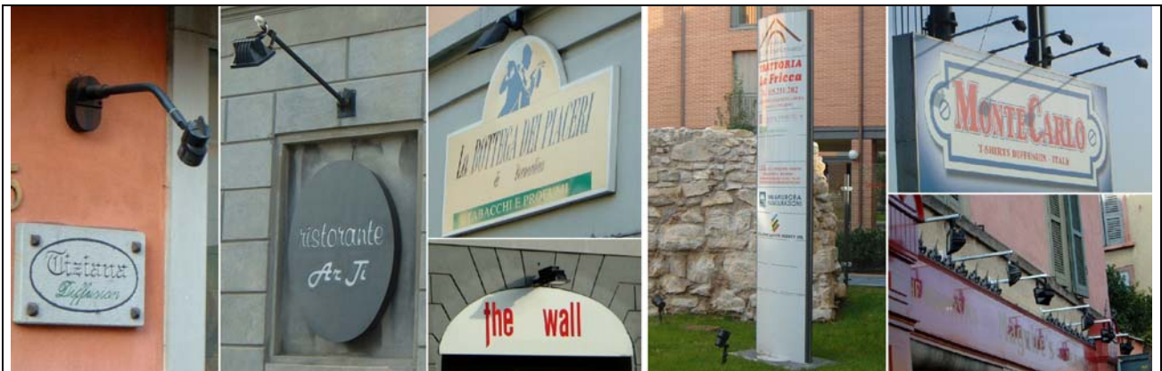
Fig.11 – Esempi di insegne prive di illuminazione propria. Le 4 illuminazioni delle insegne sulla sinistra sono conformi alla L.p. 16/07 in quanto eseguite dall'alto verso il basso con corpi illuminanti orizzontali o inclinati in modo tale che il fascio di luce viene comunque intercettato almeno dalla parete che ospita l'insegna. Nelle 3 illustrazioni di destra le insegne sono illuminate in modo non conforme alla L.p. 16/07 e rispettivamente: l'insegna a colonna è illuminata dal basso, il pannello pubblicitario è illuminato dall'alto ma con corpi illuminanti inclinati e tali da inviare luce fuori dalla sagoma e verso il cielo. Infine, nella terza immagine, l'insegna di un pub viene illuminata con apparecchi verticali e paralleli all'insegna con dispersione di luce anche oltre la sagoma dell'edificio e verso l'alto..
