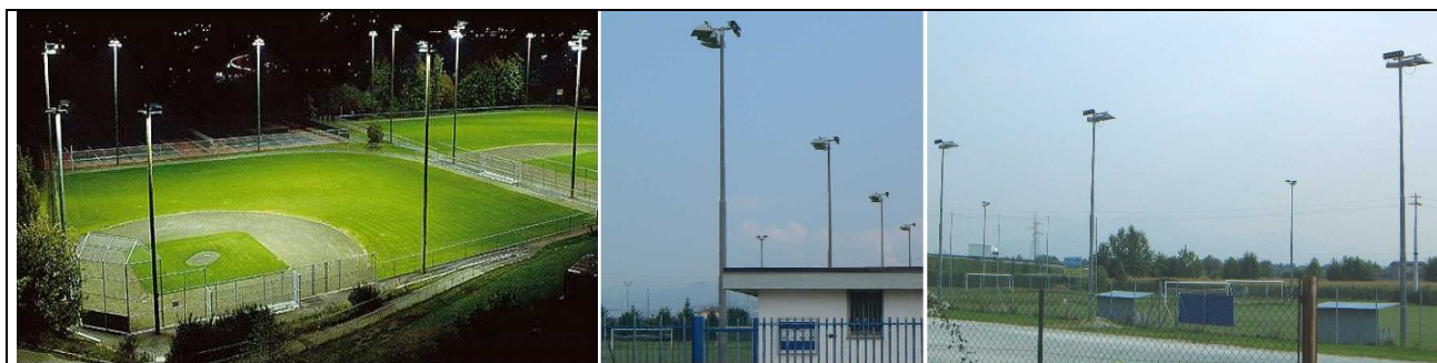
Fig. 13 – Impianti sportivi illuminati in modo conforme alla L.R. 16/07 con proiettori asimmetrici orientati orizzontalmente e che non disperdono luce verso l'alto.
