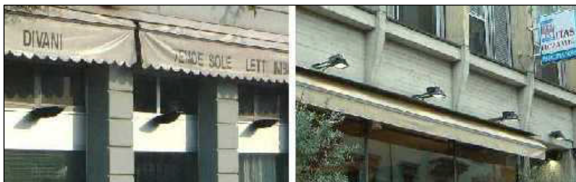
Fig. 19 (a sinistra) Una vetrina illuminata in modo non conforme alla normativa, dal basso verso l'alto. (a destra) illuminazione conforme alla D.G.R. n. 48/31
