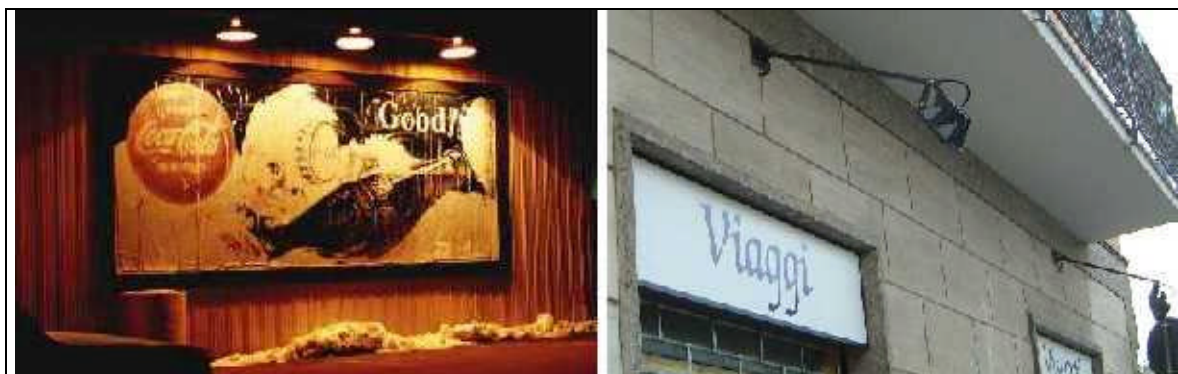
Fig. 14 –Destra: Sulla destra un'insegna di esercizio conforme alla D.G.R. n. 48/31 con emissione di 0cd/klm a 90° ed oltre.
