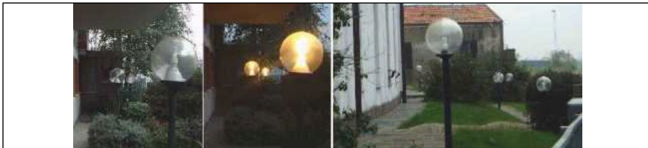
Fig. 22 – Nelle prime due foto di sinistra l'illuminazione è conforme alla deroga in quanto sono installate 3 lampadine da 18W fluorescenza compatta (flusso totale emesso 1200lumen) per un flusso emesso verso l'alto di circa 1800lumen. Nella foto di destra l'impianto è fuori legge in quanto le 5 lampade a fluorescenza compatta da 18W (1200lumen) emettono circa 3000 lumen verso l'alto.
