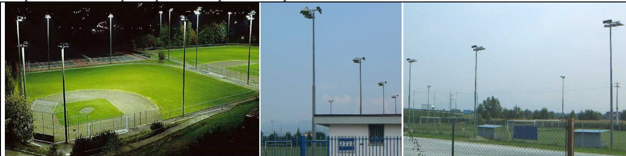
Fig. 8 – Impianti sportivi illuminati in modo conforme alla D.G.R. n. 48/31 con proiettori asimmetrici orientati orizzontalmente e che non disperdono luce verso l'alto.
