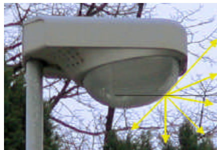
Fig. 2 Apparecchio stradale prismatico: grande emissione a piccoli angoli sopra l'orizzonte
