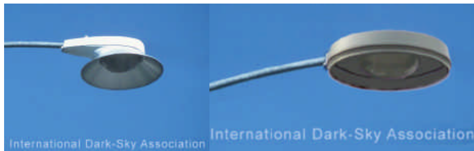
Figura 4. Due casi limite: apparecchi totalmente schermati pur con vetro prismatico (semi-cut-off)
