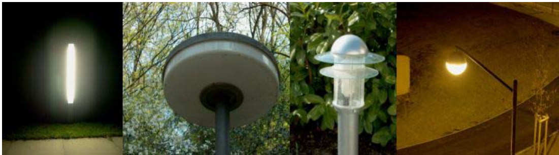
Abbildung 14: Beispiele schlechter Aussenleuchten, aus Sicht der Lichtverschmutzung
