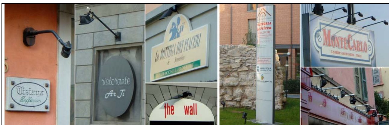
Fig. 20 – Esempi di insegne prive di illuminazione propria. Le tre insegne di sinistra sono conformi alla L.r. 2/10 in illuminante dall'alto verso il basso con apparecchi orizzontali o inclinati ma con flusso intercettato dalla parete. A destra 2 insegne non conformi alla L.r. 2/10 in quanto la prima è illuminata dal basso e il pannello pubblicitario è illuminato dall'alto ma con corpi illuminanti inclinati con flusso non intercettato dalla sagoma.
