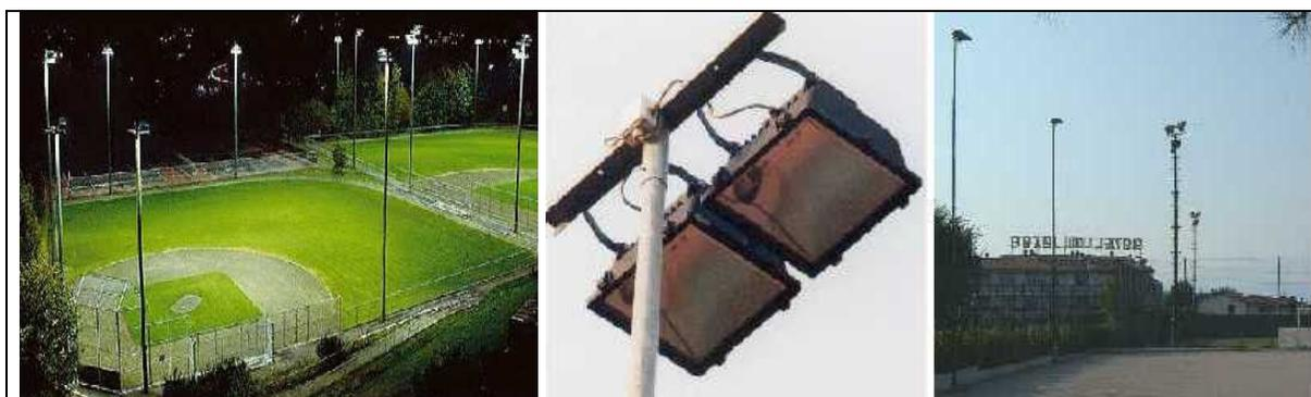
Fig.1-6 - Impianti sportivi illuminati in modo conforme alla L.R.10/02 con proiettori asimmetrici orientati orizzontalmente e che non disperdono luce verso l'alto.
