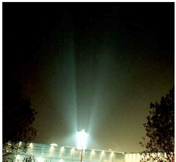
L'utilizzo della luce riflessa mediante apparecchiatura "Vela" come illuminazione urbana, residenziale, decorativa, etc.. è sempre sconsigliata in quanto tali sistemi hanno un'efficienza molto bassa ed è quasi impossibile non inviare luce verso la volta celeste! In questo caso i potenti proiettori colpiscono solo parte del corpo riflettente disperdendo il resto del flusso luminoso verso l'alto (F.Crotti)
