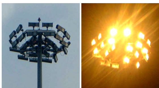
I riflettori simmetrici di questa torre faro – di giorno e di notte - inviano buona parte della luce verso il cielo, quasi il 50% (F.Arcidiacono).
