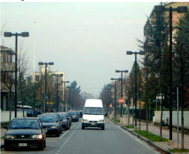
Impianto di Illuminazione stradale full cut-off con una razionale distribuzione dei corpi illuminanti (D.Bonata).
