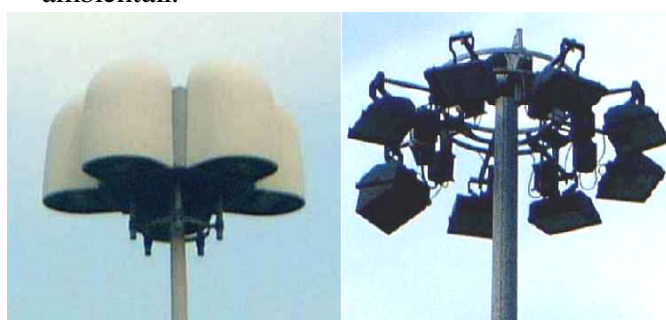
L'utilizzo di fari asimmetrici permette di costruire torri faro totalmente schermate anche di notevoli dimensioni. Nella foto di destra si ha avuto l'accortezza di limitare (la dove non serviva) il flusso luminoso con degli schermi applicati sul riflettore (F.Zanotti)
