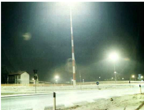
Svincolo di Malpensa 2000 - Impianto di faraonica mostruosità progettato con corpi distribuiti su 3 anelli, a 45° verso il basso, orizzontali e puntati a 45° VERSO L'ALTO. E' visibile da 30km di distanza ed i 2/3 della luce viene usata per illuminare il cielo. Costruita all'interno del Parco naturale del Ticino. (S.Minuto).
