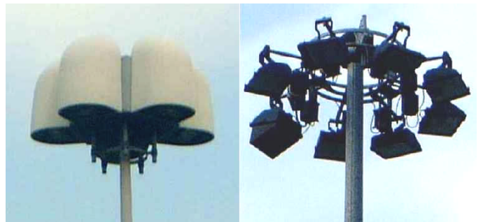
L'utilizzo di fari asimmetrici permette di costruire torri faro totalmente schermate anche di notevoli dimensioni. Nella foto di destra si ha avuto l'accortezza di limitare (la dove non serviva) il flusso luminoso con degli schermi applicati sul riflettore (D.Bonata)
