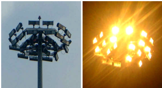
I riflettori simmetrici di questa torre faro – di giorno e di notte - inviano buona parte della luce verso il cielo, quasi il 50% (D.Bonata).
