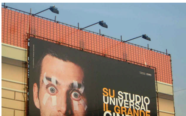
Milano - Le insegne devono essere illuminate dall'alto verso il basso. L'inclinazione delle lampade deve controllare il flusso luminoso solo sulla sagoma
