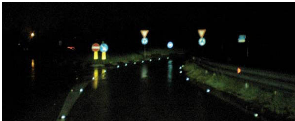
Figura 22: Svincolo autostradale dotato di eyes-cat
