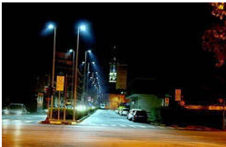
Figura 13: Illuminazione stradale con apparecchi al Led
