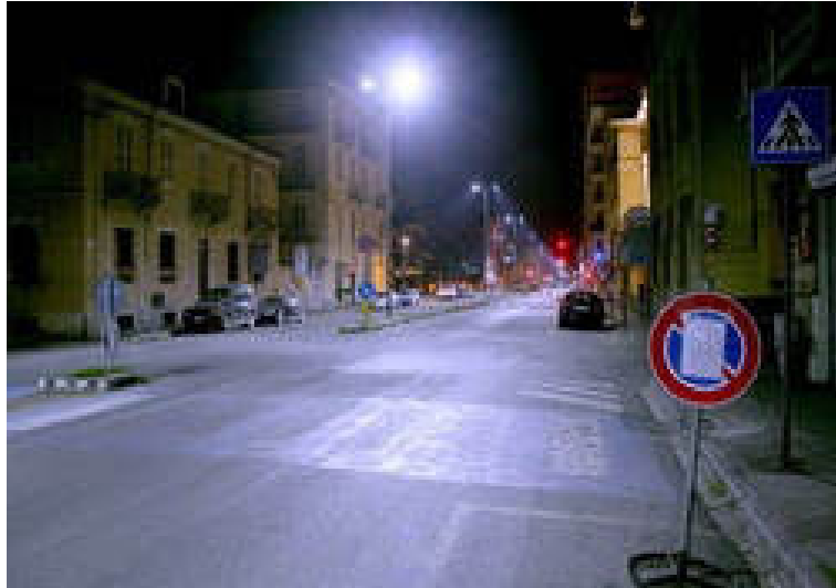
Figura 16: Illuminazione stradale al led
