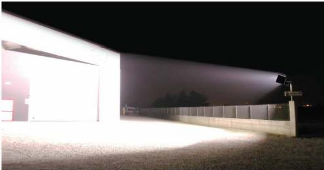
Una nostra simulazione di come si potrebbe illuminare senza inquinare. Basta montare le alette paraluce sul faro (in commercio se ne trovano di tutte le misure) e orientarle per dirigere la luce esattamente dove occorre, oppure usare proiettori asimmetrici.
