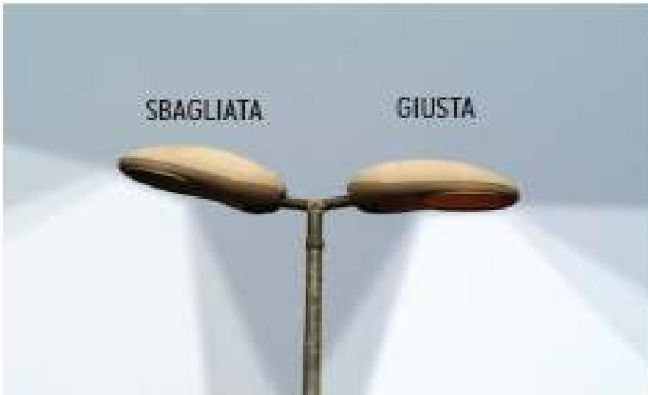
Due ottime armature full cut-off. Quella a sinistra è stata però installata in maniera errata, in quanto è stata data un'inclinazione verso l'alto che, di fatto, altera i parametri illuminotecnici, modificando la quantità di luce che giunge a terra e provocando al contempo forte inquinamento luminoso.
