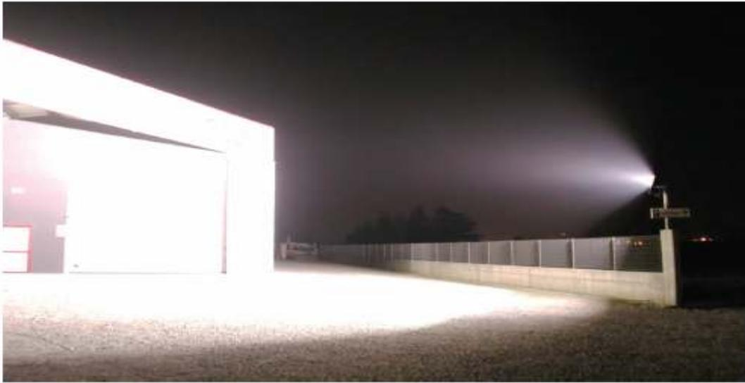
Remanzacco (UD). Una nuova illuminazione eccessiva. Il faro simmetrico usato per illuminare il capannone, è posizionato talmente male che disperde oltre la metà del flusso luminoso (oltre il 50% della luce irradiata da questo faro sale inutilmente verso il cielo), rendendo sovrailluminata la porzione di terreno interessata dal fascio e, naturalmente, il capannone. Foto [C.A.S.I.](#)
