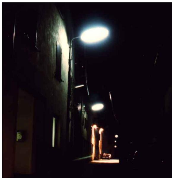
*Un pessimo esempio di doppio impianto: in primo piano lampade a fluorescenza non illuminano la strada ma le finestre circostanti, e sullo sfondo un impianto giustamente full cut-off al sodio ad alta pressione ma sovradimensionato per le effettive esigenze della strada. (G.Agostoni).*
