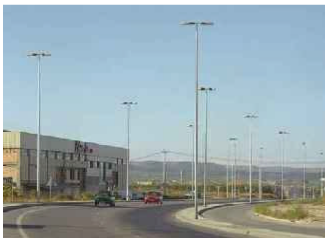
Impianto di Illuminazione stradale full cut-off nei pressi di Bergamo, con una razionale distribuzione dei corpi illuminanti.
