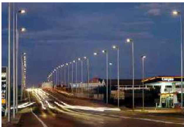
Impianto di Illuminazione stradale full cut-off ma dove si sarebbe potuto ridurre notevolmente il numero di corpi illuminanti.
