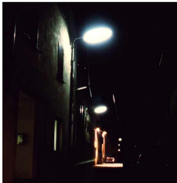
*Un pessimo esempio di doppio impianto: in primo piano lampade a fluorescenza non illuminano la strada ma solo le finestre circostanti, e sullo sfondo un impianto giustamente full cut-off al sodio ad alta pressione ma sovradimensionato per le effettive esigenze della strada. (G.Agostoni).*
